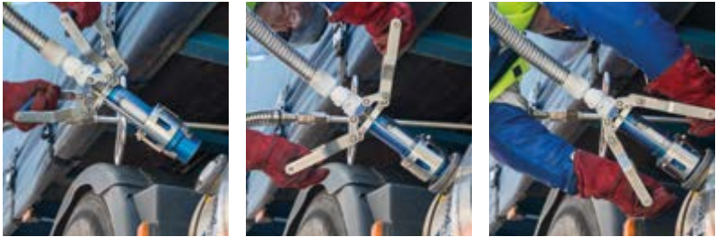
Detalle da conexión da manguera de GNL ao vehículo
